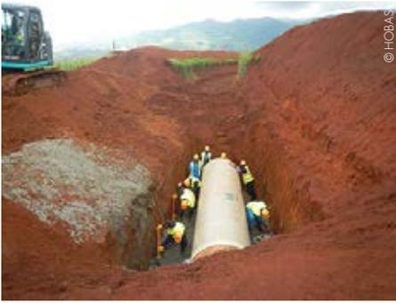
Verlegung von HOBAS Rohren in Uganda bei Kraftwerksbau
