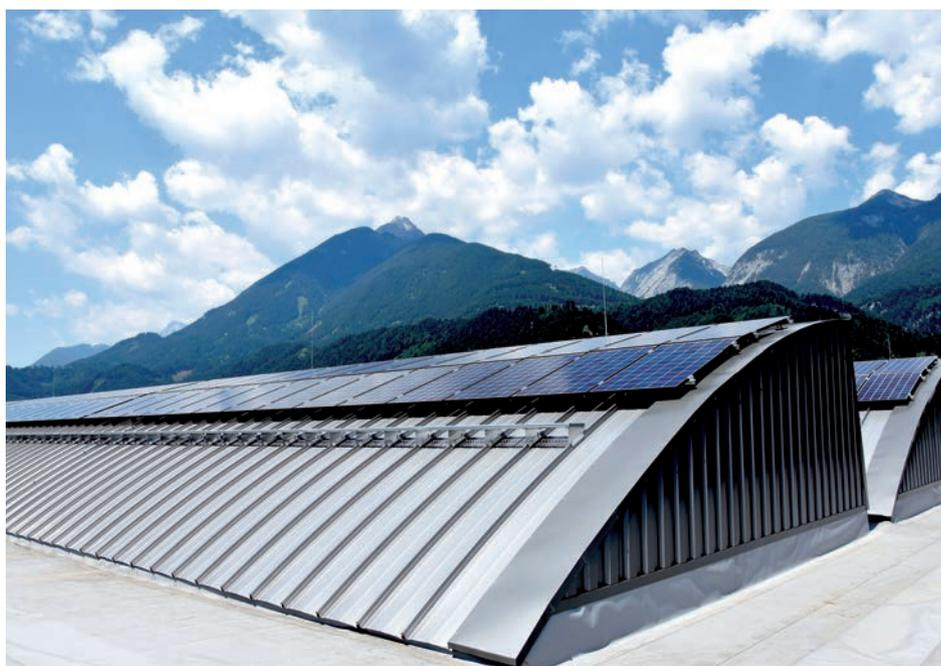
Elegantes Silberkleid: Die Fassade der neuen Fabrik ist mit der Vergrauungslasur Pullex Silverwood von ADLER beschichtet. Eine moderne Photovoltaikanlage auf dem Dach versorgt die neue Produktionsanlage mit Strom.
