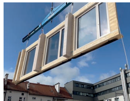
Die ersten Wandelemente wurden bereits montiert.
