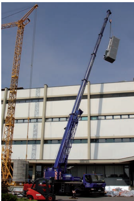
Einbringung der Wärmekammer in 22 m Höhe
