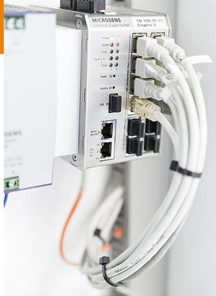
Die MICROSENS Smart Engine übernimmt die Energieversorgung der Leuchten über Standard-datenkabel
