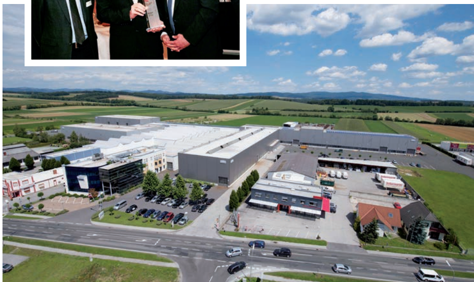
Headquarter im Zentrum Europas: Die Unger-Zentrale im burgenländischen Oberwart
