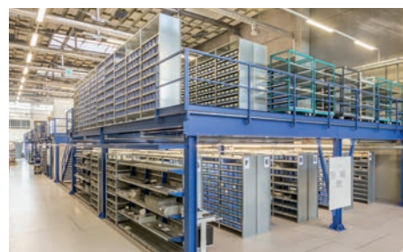
Firma Hörbiger erhält eine neue Lagerbühne
