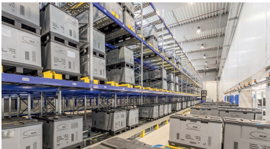
Einrichtung eines Palettendurchlaufregallagers für die Firma ZKW.
