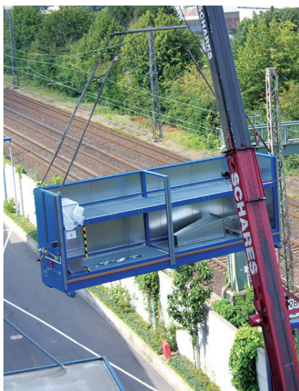
Herausforderungen gemeistert: Wärmekammer bei Einbringung und fertig montiert.
