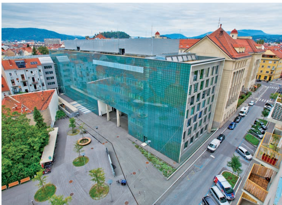
An der TU Graz werden Gleichspannungsnetze geprüft.
