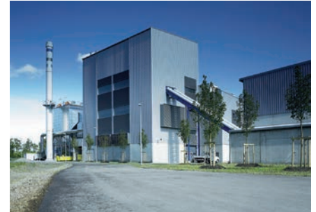
Kraftwerksanlage der BERTSCHenergy
