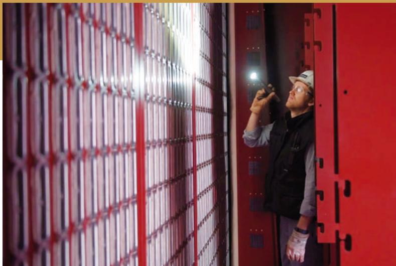
Mit der weltweit größten Tuchfilteranlage für die Sintererzeugung geht der Industriekonzern thyssenkrupp einen entscheidenden Schritt in Sachen Abluftreinigung voran.
