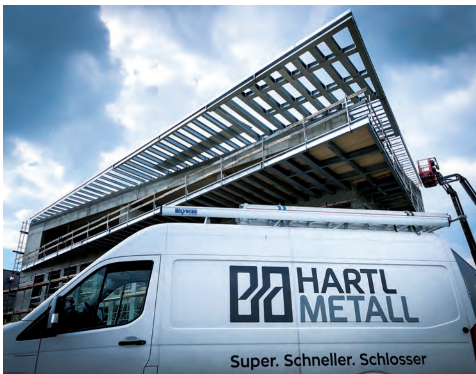
Hartl Metall errichtet eine spektakuläre Vordach-Konstruktion im Wirtschaftspark Stadtgut Steyr: Bis zu sechs Meter überragt das Vordach den Zubau von Burg Design.
