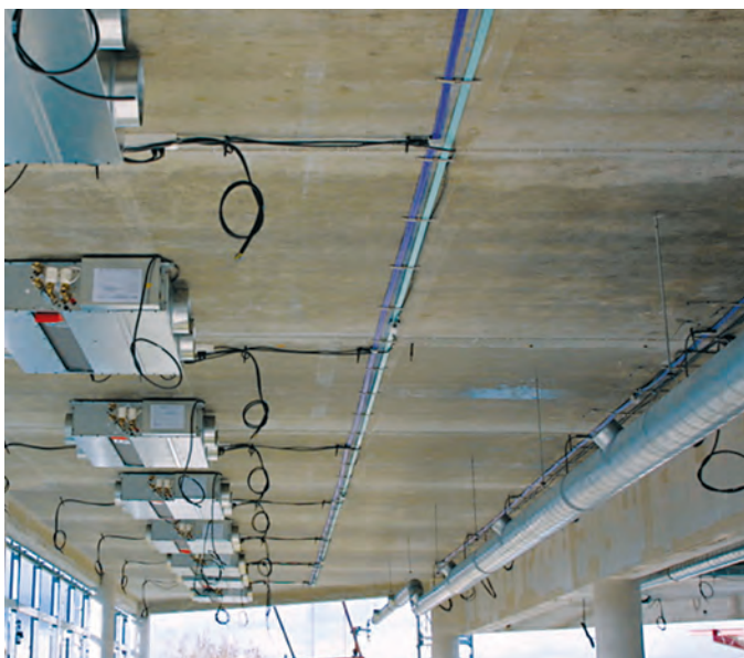
Flachkabelsysteme – vorgefertigte Systemlösungen sind kosten- und zeitsparend.
