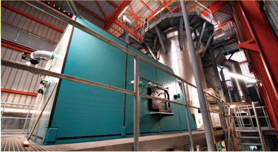
Hydraulischer Vorschubrost mit aufgesetztem Thermoölkessel
