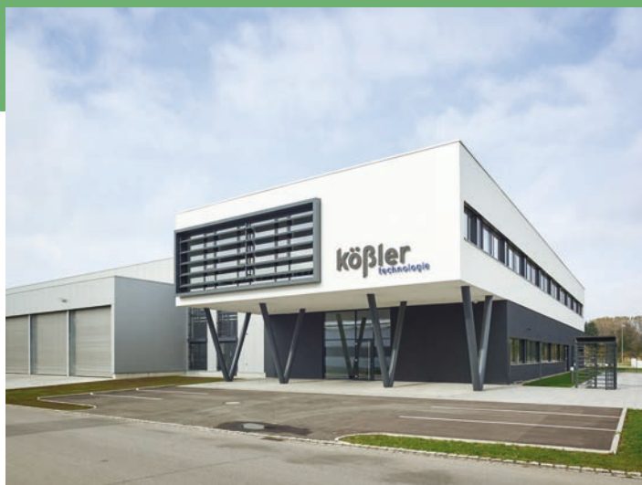
Der intelligente Neubau der Köblier Technologie GmbH in Babenhausen.
