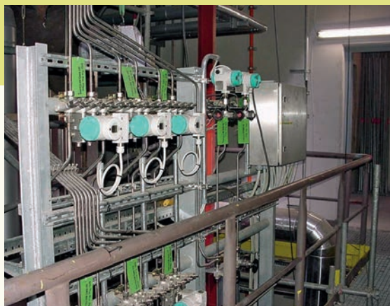
Geräterack und Schaltschrank
