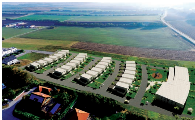
NÖ: In Sommerein entsteht der „Wohnpark Wolfsbrunn“, der erste soziale Wohnbau Niederösterreichs mit thermischer Bauteilaktivierung (TBA).
