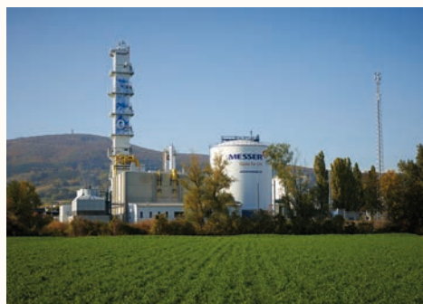
Luftzerlegungsanlage der Messer Austria GmbH am Standort Gumpoldskirchen
