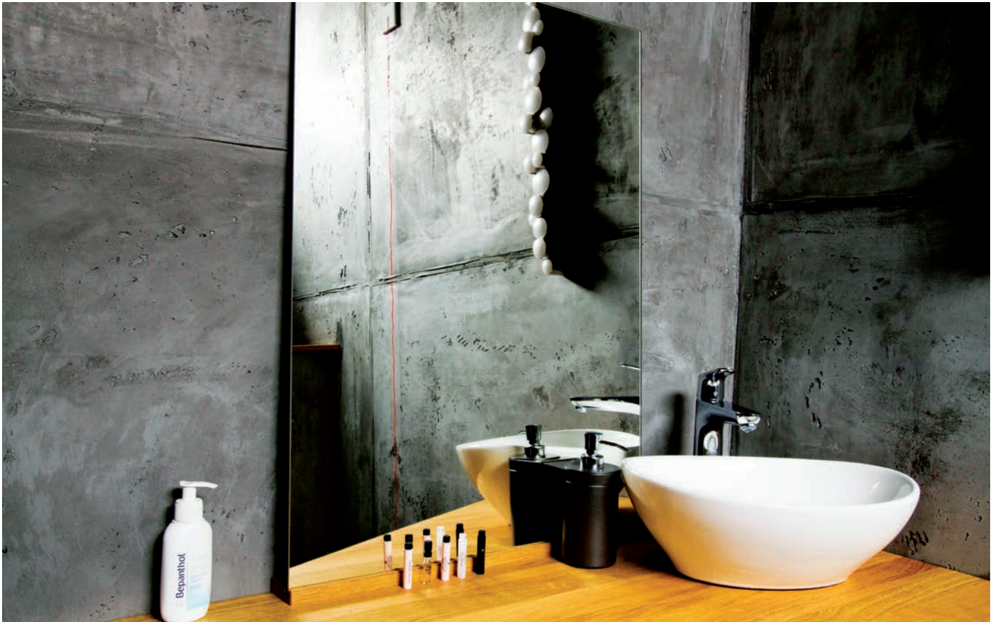
Durch die spezielle Spachteltechnik sieht das Endergebnis aus wie „echter“ Sichtbeton.
