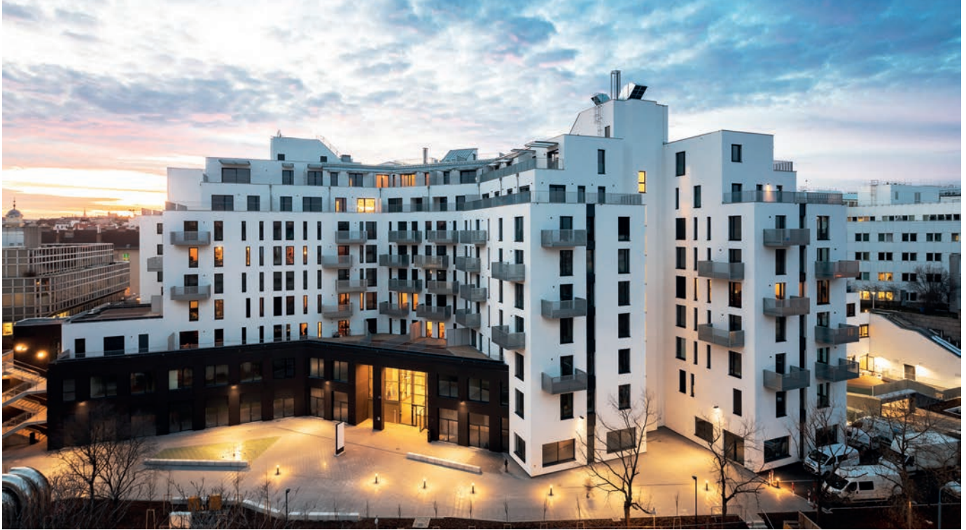
Beim 6B47-Projekt Althan Park in 1090 Wien handelt es sich um ein gemischt nutzbares Gebäude mit einer Wohnfläche von insgesamt 18.000 Quadratmetern und 240 Wohneinheiten.
