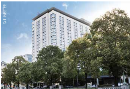
Das Hilton Vienna Stadtpark wird zur Zeit modernisiert und ausgebaut.
