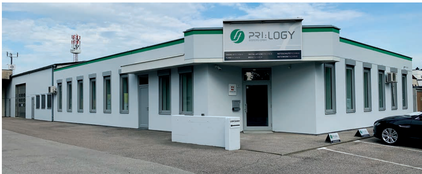
Das PRI:LOGY Headquarter in Pasching wurde modernisiert – sowohl innen als auch außen.
