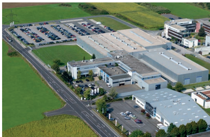
PIA Automation Austria Firmengebäude
