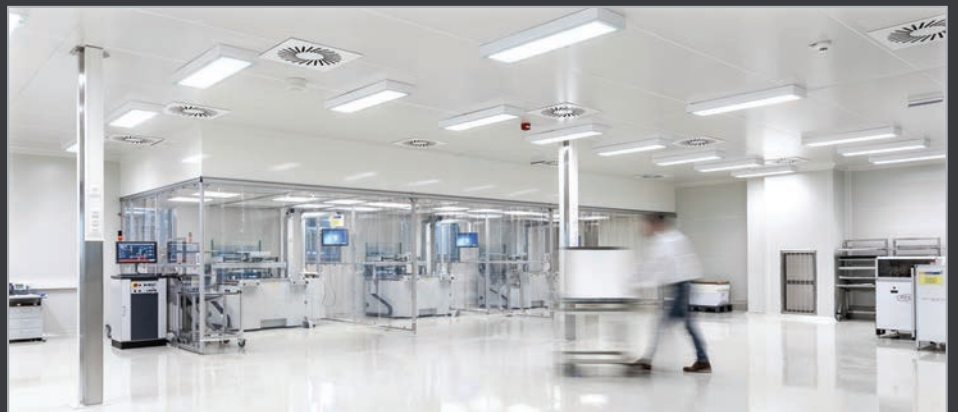
BRUCHA Reinraumbau für Automotiv- und Pharmaindustrie sowie Prüflabors
