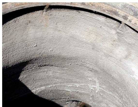
Schacht nach der Sanierung mit Vortex GeoKrete®
