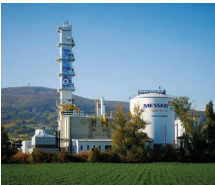
Luftzerlegungsanlage der Messer Austria GmbH am Standort Gumpoldskirchen
