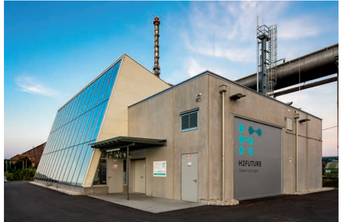
Die derzeit weltgrößte Pilotanlage zur CO 2 -freien Herstellung von Wasserstoff hat am voestalpine-Standort in Linz erfolgreich ihren Betrieb aufgenommen
