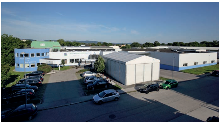
Die VSL-Zentrale in Biedermannsdorf, in der das Unternehmen seit 2002 die Geschäfte leitet.
