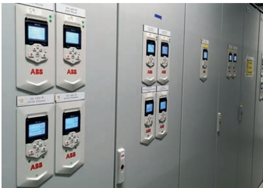
ACS 880 Frequenzumrichter werden für Fördertechnik- und Pumpenanwendungen genutzt
