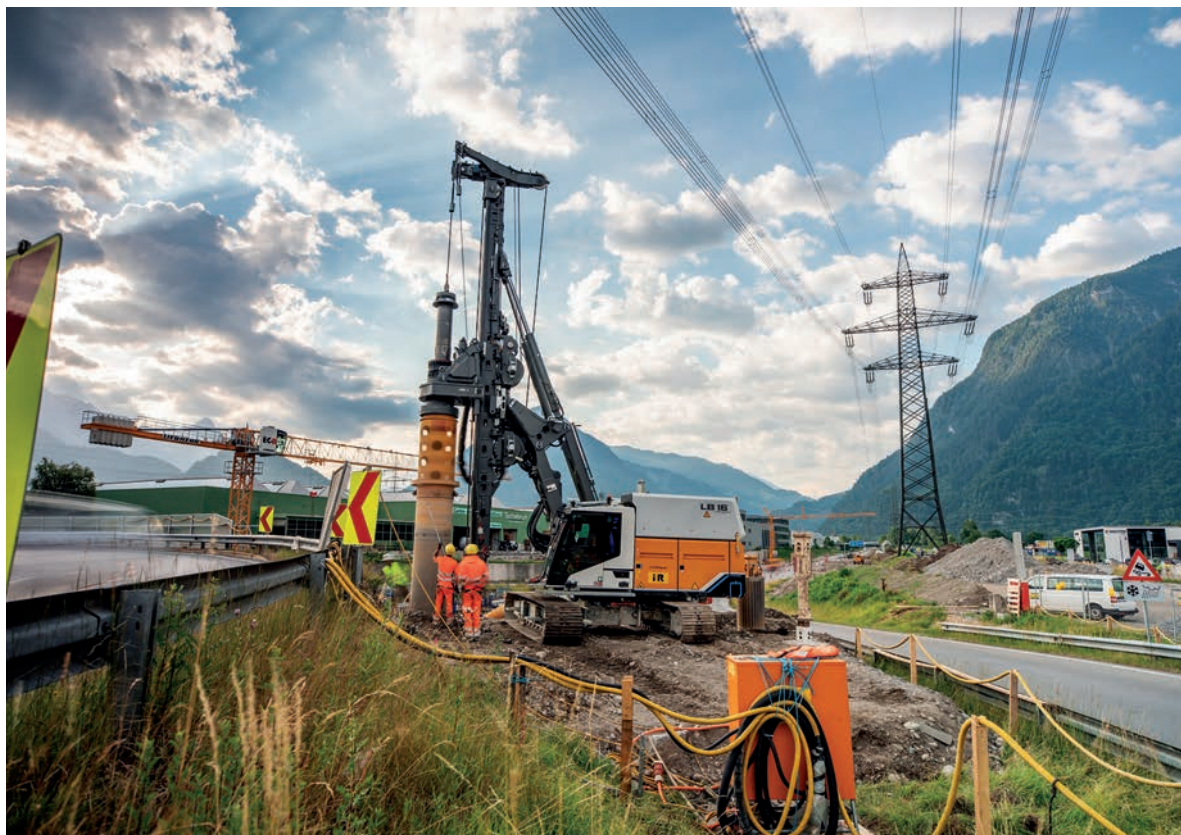
Verkürzt: Wegen der Hochspannungsleitung ist das Bohrgerät als Low Head ausgeführt.
