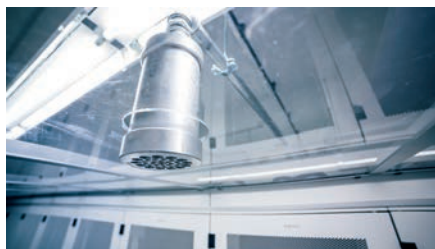
Die SILENT-Düsen Schalldämpfer vermindern den Schalldruckpegel des einströmenden Löschgases und schützen die Hardware so vor vibrationsbedingten Beschädigungen.
