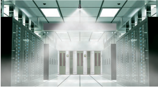
Im Fall eines Brandes wird das Rechenzentrum homogen mit dem Löschgas geflutet.
