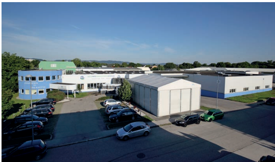
Die VSL-Zentrale in Biedermannsdorf, in der das Unternehmen seit 2002 die Geschäfte leitet
