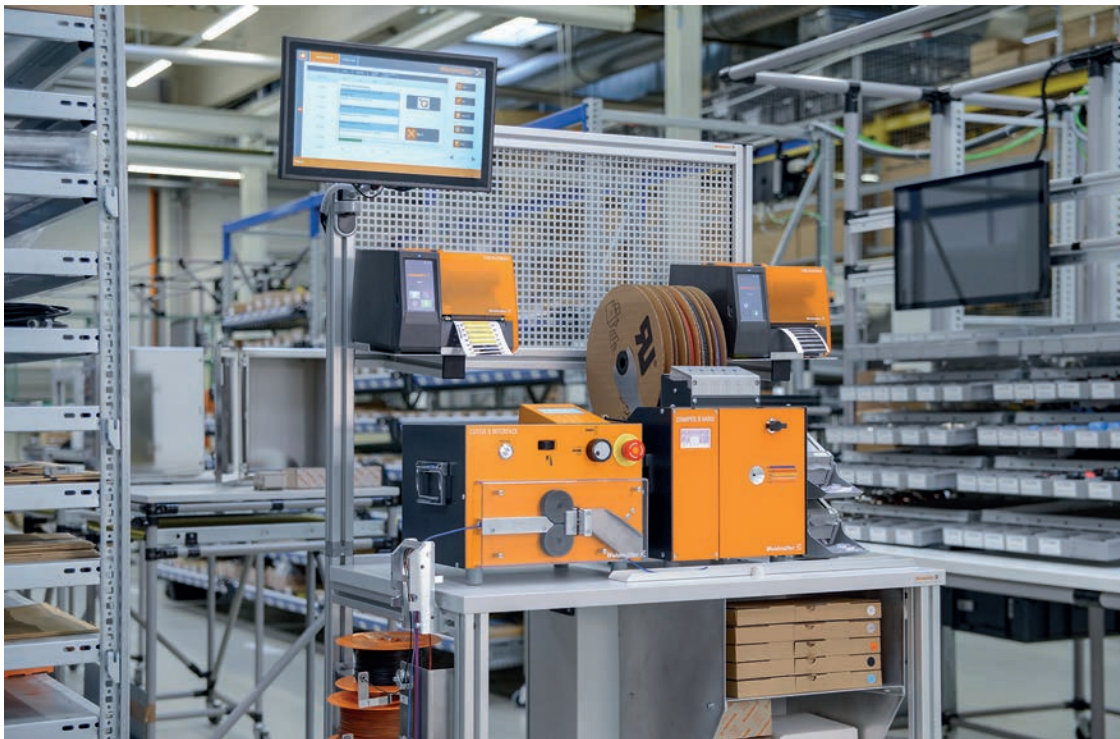
Das WPC besteht aus einem Ablängautomaten, einem Abisolier- und Crimpautomaten sowie einem Thermotransferdrucker.
