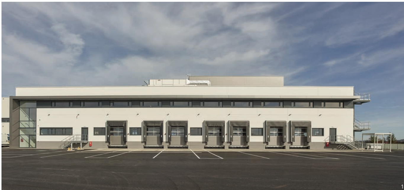
Insgesamt standen 65.000 m 2 Grundfläche für das neue Werk II zur Verfügung.
