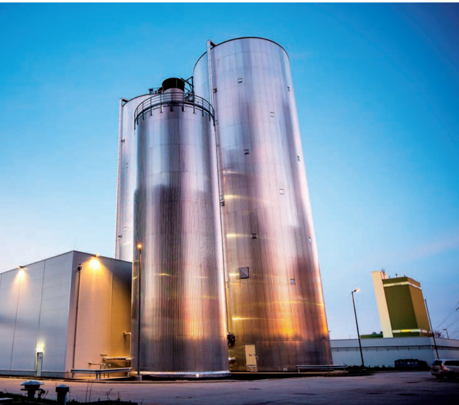
Hochdruck-Wärmespeicher sorgen für die Speicherung der produzierten Energie.
