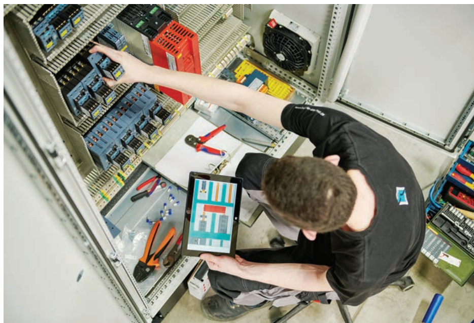
Digitale Unterstützung bei der Verdrahtung direkt am Schaltschrank dank „Schaltschrankbau 4.0“
