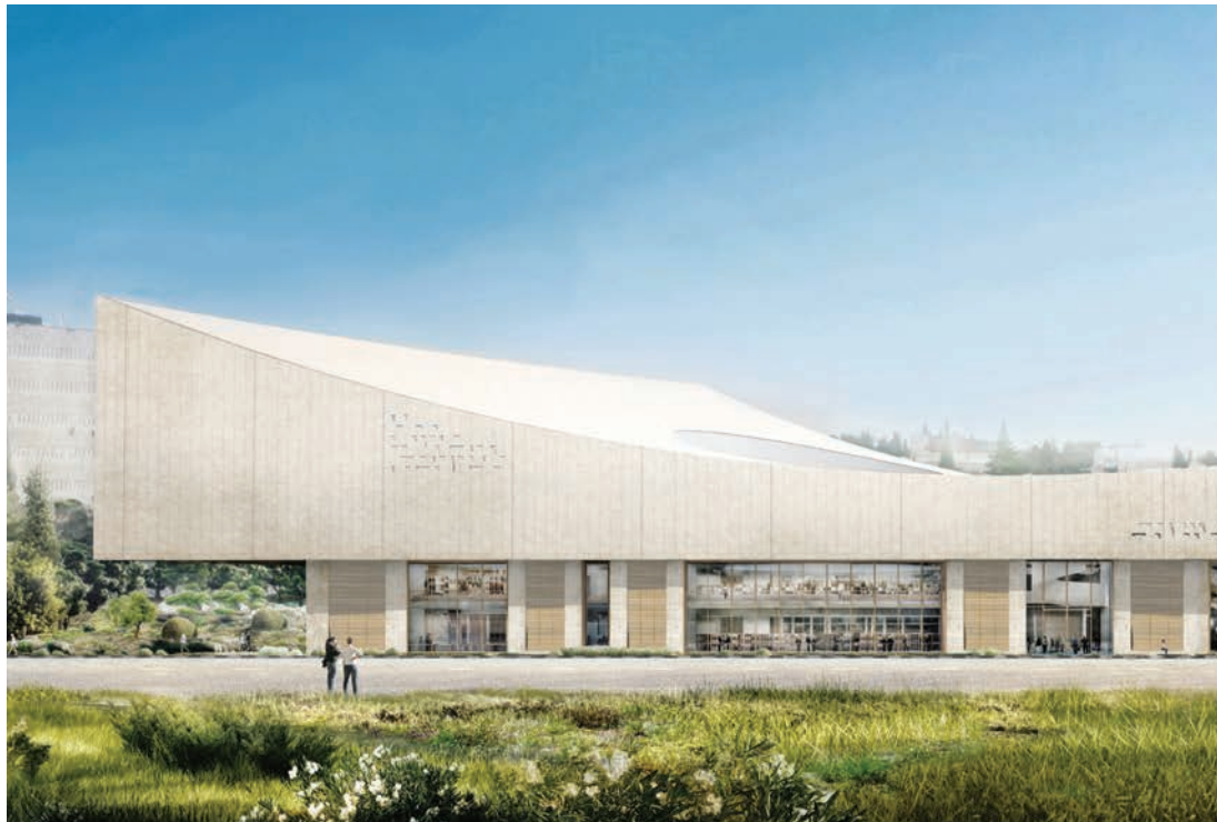
Das neue Gebäude liegt zwischen dem Parlament und dem israelischen Museum in Jerusalem.
