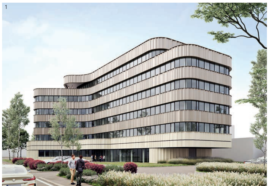
Der Strabag-Neubau wird parallel zum Löwenzahnweg errichtet.
