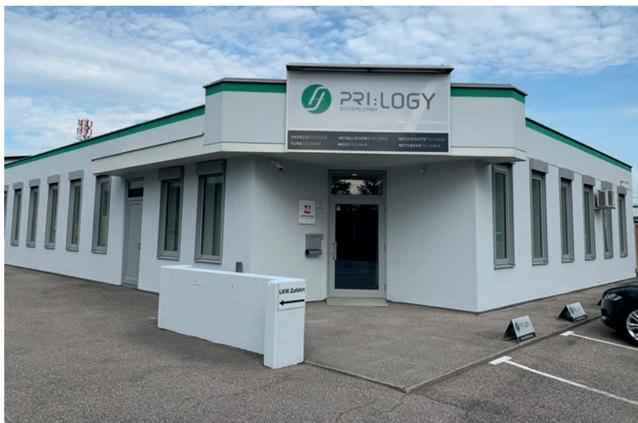
Das Pri:Logy-Firmengebäude in Pasching
