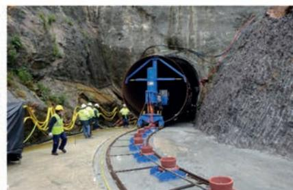
Durch Anwendung modernster Sicherheitstechnologien und Mehrseiltechnik an den Winden wurde neben der Vereinfachung der Arbeitsschritte auch die Arbeitssicherheit signifikant erhöht.
