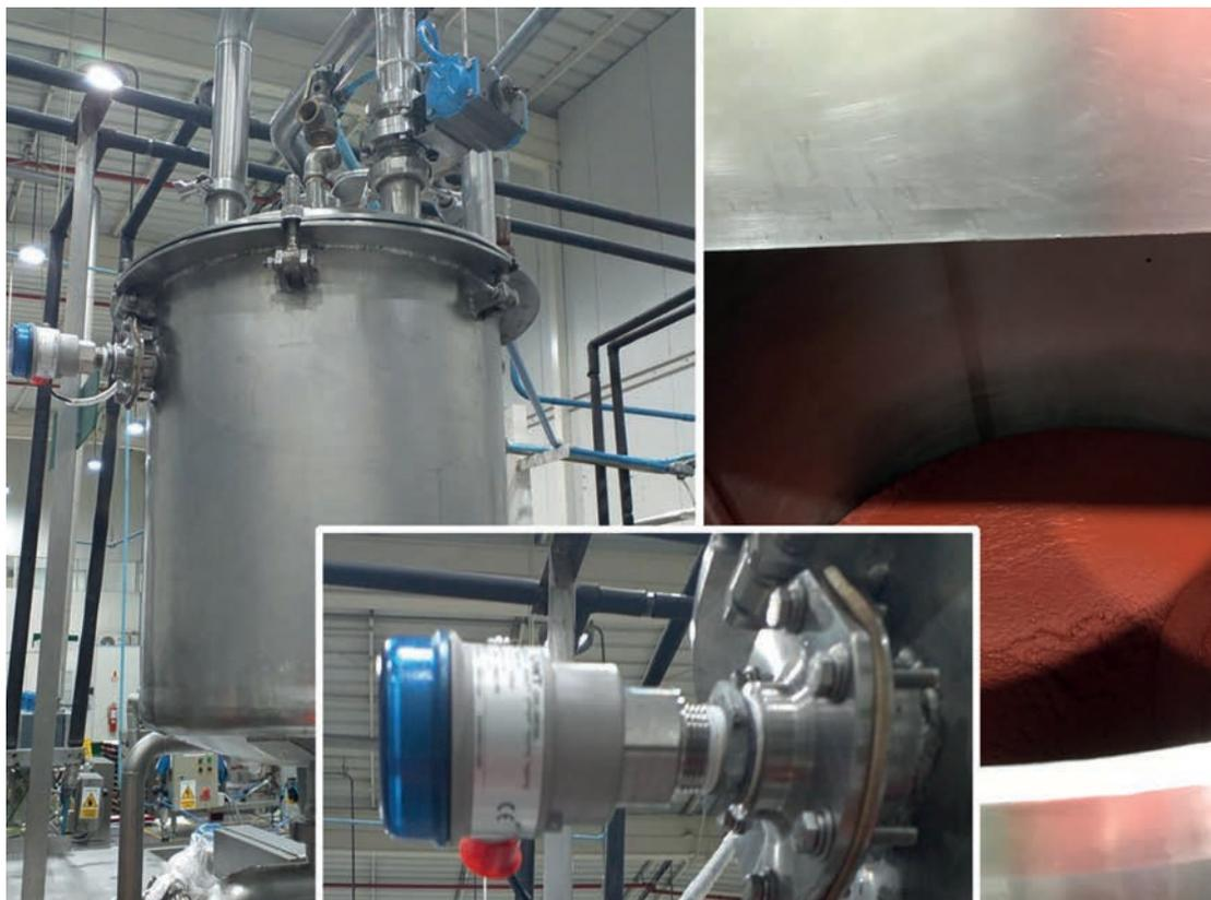
*Seitliche Montage des kapazitiven Grenzschalters Capanivo® CN 7000 zum Überfüllschutz bei der Anwendung mit Tomatenmark. Das Design des verwendeten Sensors impliziert lebensmittelkonforme Materialien und ist universell einsetzbar.*
