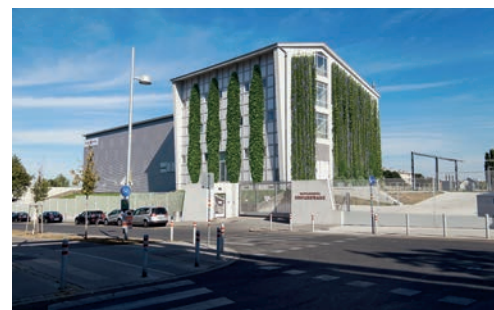
90 Pflanzen begrünen das Wiener-Netze-Schaltanlagen-Gebäude des Umspannwerks Kandlerstraße.
