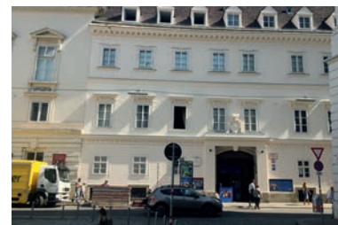
Palais Palffy, Wien, Sanierung Fassade
