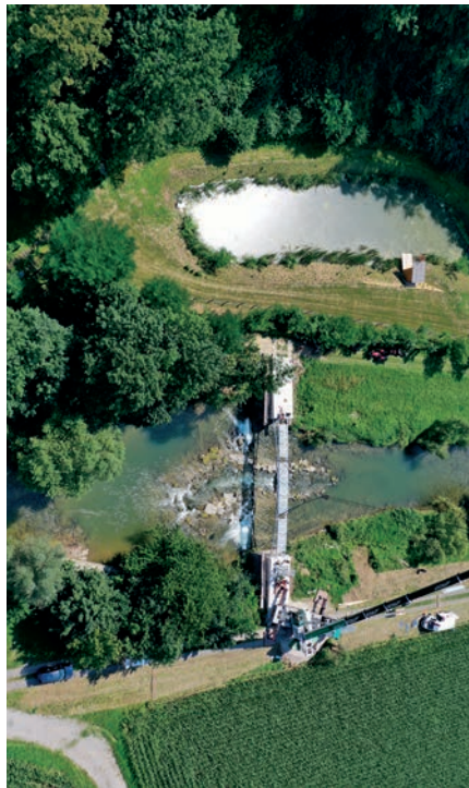
Die Stahl-Rohrbogenbrücke bringt Wanderer sicher über die Melk.
