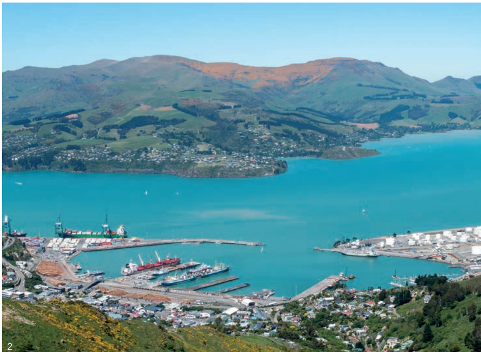
Seit Oktober 2020 ist Gebrüder Weiss nun auch im neuseeländischen Christchurch mit eigenem Standort vertreten. Im Bild: das Containerterminal am Seehafen Lyttelton Port
