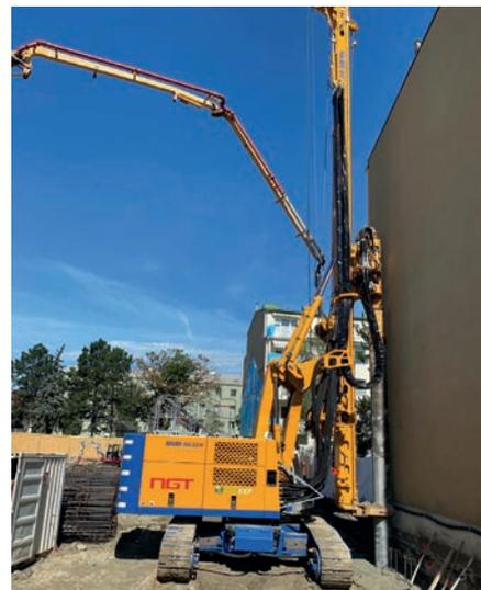
Bohrpfahlgerät BG 23 beim VDW-Bohren
