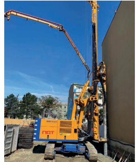
Bohrpfahlgerät BG 23 beim VDW-Bohren
