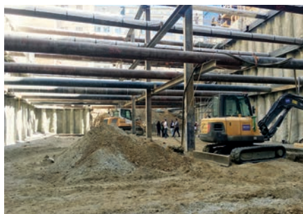
Baugrubensicherung, aufgelöste Bohrpfahlwände, abgestützt, Baugrubentiefe 14 m, in der Renngasse 10, 1010 Wien
