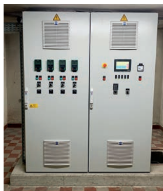
Bild li.: Gebäudefunkanlage in 19"-Technik Bild re.: Pumpwerk Magistrat Klagenfurt, Völkermarkter Straße
