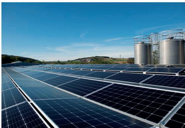
*1.438 Solarzellen auf rund 3.600 m<sup>2</sup> Dachfläche decken bis zu 38 % des Strombedarfs am Produktionsstandort Würmla. Damit erspart Miraplast der Atmosphäre jedes Jahr 121 t CO<sub>2</sub>.*
