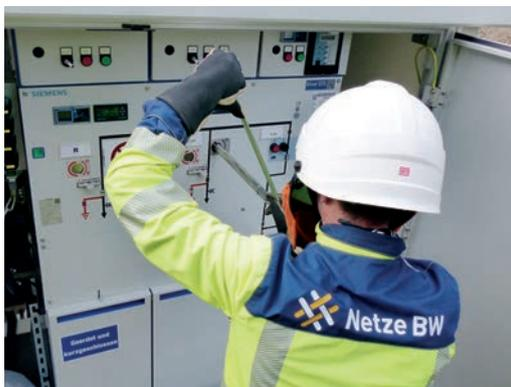
Die neue F-Gas-freie Ringkabelschaltanlage 8DJH 24 ist seit Herbst 2020 im Rahmen einer Entwicklungskooperation mit Netze BW in einer Ortsnetzstation im Oberallgäu, Deutschland, im Einsatz.
