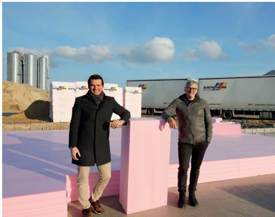
Heimo Pascher (li.) und Klaus Haberfellner bei der Verlegung der hochdruckfesten Austrotherm XPS TOP 70 mit einer Dämmdicke von 40 cm.
