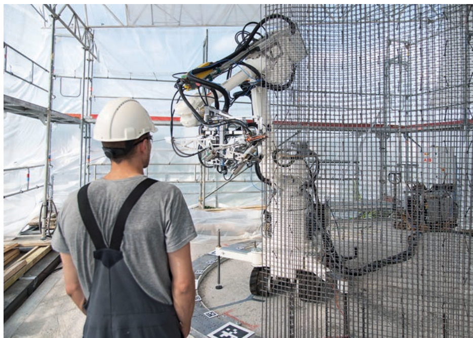
Durch eine roboterbasierte Schweißanwendung können Stahl-Bewehrungskörbe vor Ort hergestellt werden.
