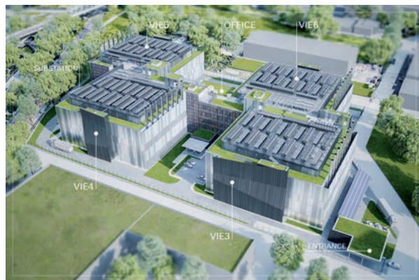
Der Digital Park Pauerwerkstraße vereint vier Rechenzentren an einem Standort.
