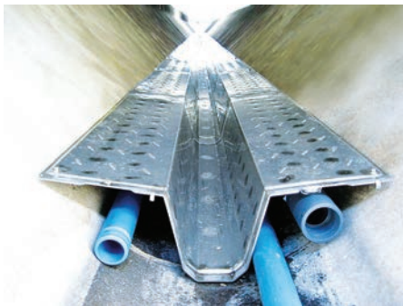
Rinnenförmige Wärmetauscher machen die Energie des Abwassers nutzbar.
