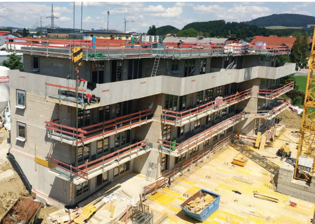
Ein kürzlich abgeschlossenes Wohnbauprojekt mit Holzbeton in Neumarkt
