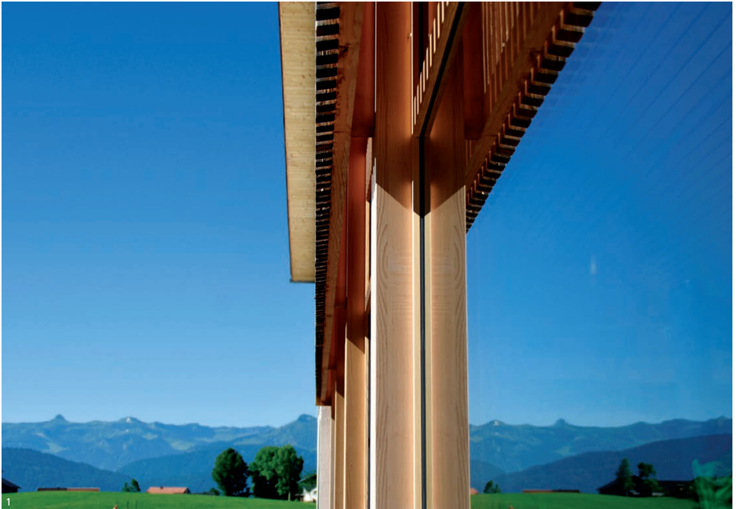
Sanierung einer Volksschule in Langenegg mit Neubau einer Turnhalle. Architekt: Walter Beer – baukultur Management GmbH
