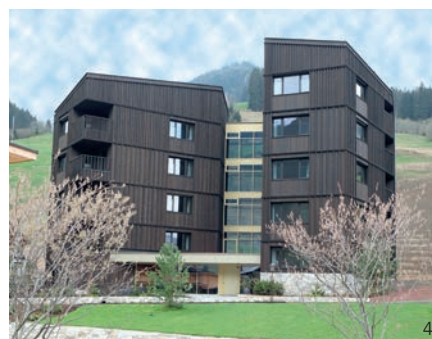
Neubau in Holz im Familienresort Moar Gut
