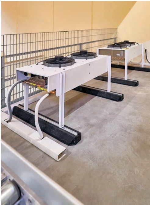
Die Wärmeenergie aus den Racks wird von zwei vor dem Raum aufgestellten externen Verflüssigern an die Umgebung abgegeben. Das bedeutet: kein Aufheizen des Backup-Zentrums (Bild links). DI Gerhard Wagner, Bereichsleiter IT, und Benedikt Hartl, Abteilungsleiter IT-Systemadministration, freuen sich über das neue Rechenzentrum (Bild rechts).
