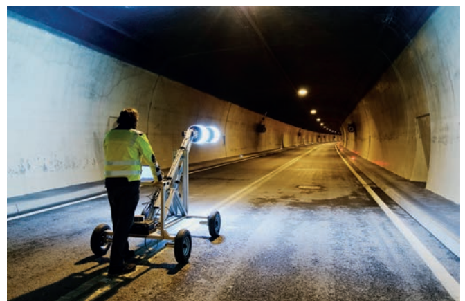
Ein Dibit-Ingenieur scannt einen bestehenden Tunnel auf Oberflächenbeschädigungen wie beispielsweise Risse.
