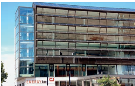
Passivbürohaus EnergyBase: energieeffizient, umweltbewusst, modern.
