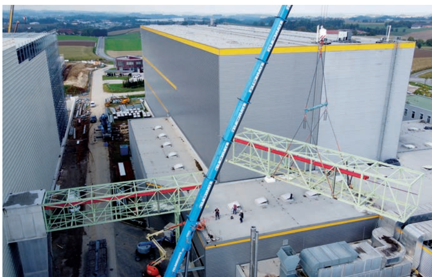
Mittels 300 Tonnen Kran wurden die beiden vormontierten Teile punktgenau eingehoben.
