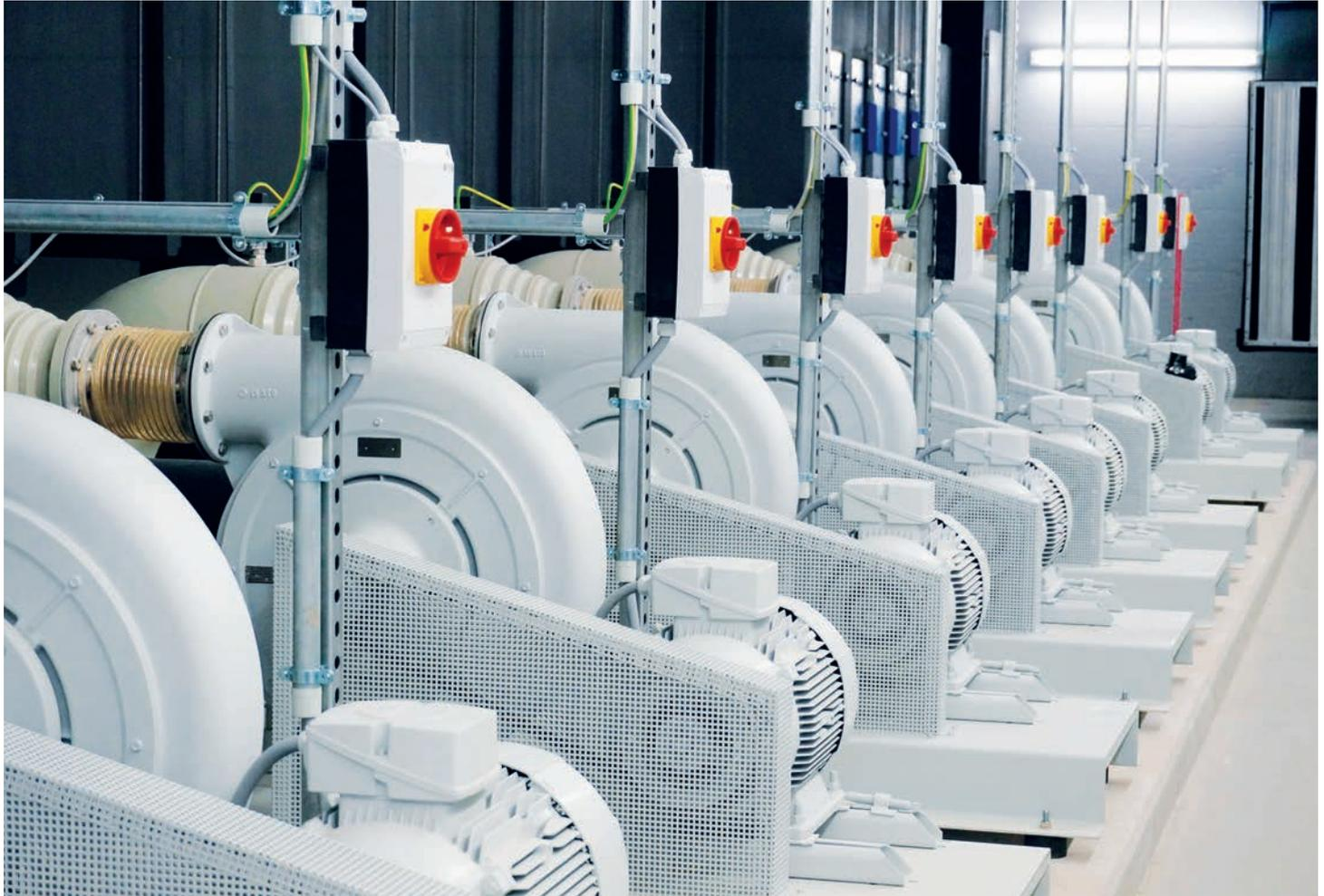
*Hochdruckventilatoren von Elektror airsystems im Einsatz*
