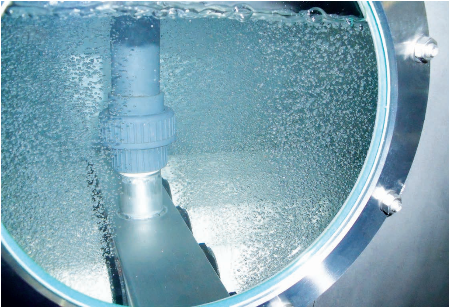
Feinblasige Luftverteilung bei der Wasseraufbereitung
