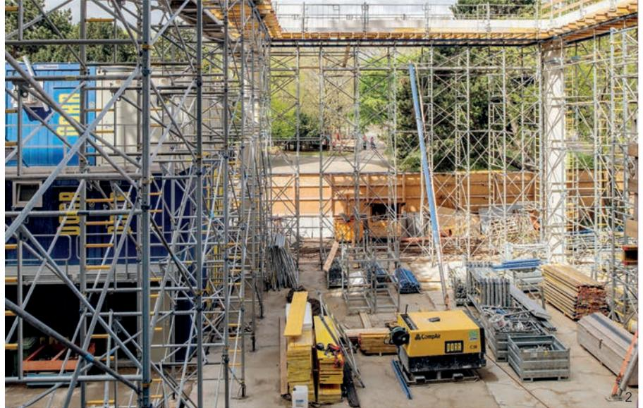
» schwebt mittels einer autonomen Stahlkonstruktion über dem Altbestand. Im Innenhof haben wir als tragende Struktur auf 41 Bohrpfehlen ein viergeschossiges Atrium gegründet. Das hängende Stiegenhaus im Atrium und die runde Atriumdecke waren baulich die größten Herausforderungen.“
